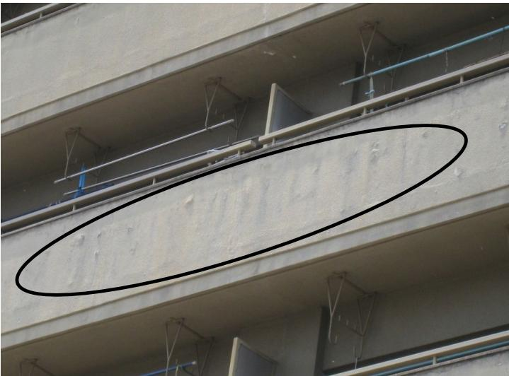
手摺壁の天端・手摺支柱周りからの漏水による。
