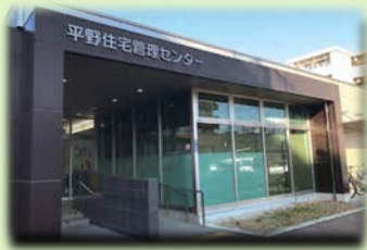
平野住宅管理センター
