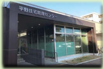
平野住宅管理センター
