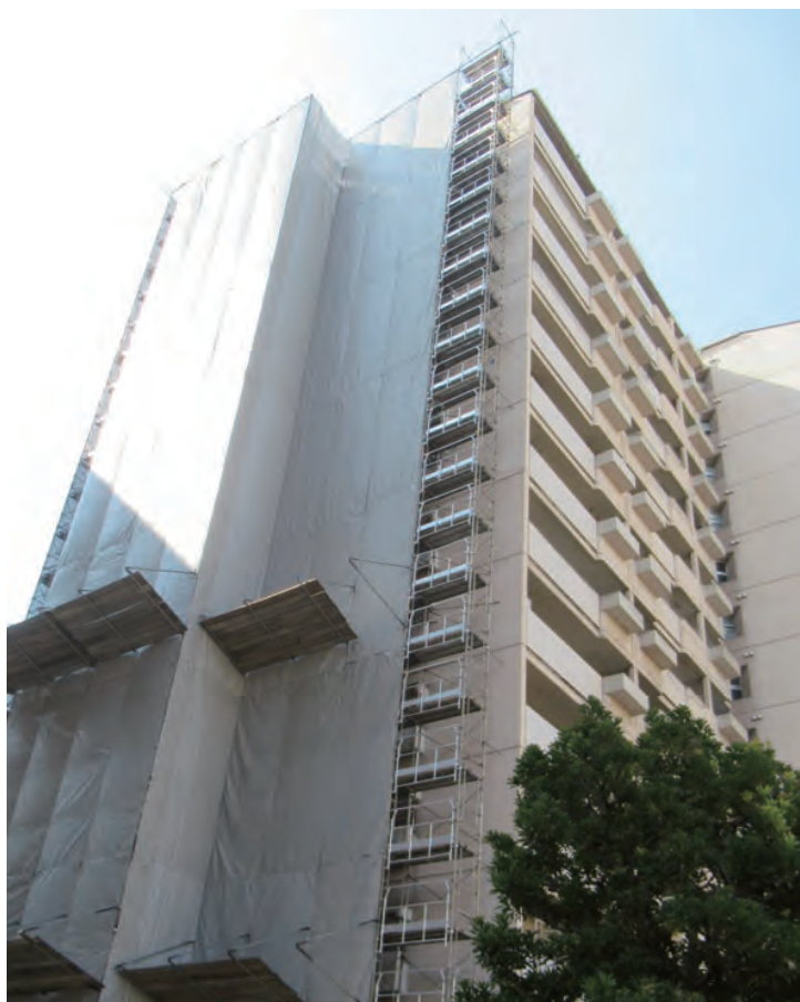
(左) 外壁改修工事の実施状況 (右上) 外壁や屋上防水、設備等の計画改修設計業務を実施 (右下) 外壁の劣化損傷を確認するための打診調査の様子
