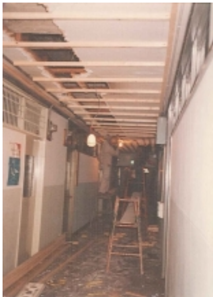
写真 5-5 2 階事務所廊下天井の改修 ( 昭和 50 年ごろ )
