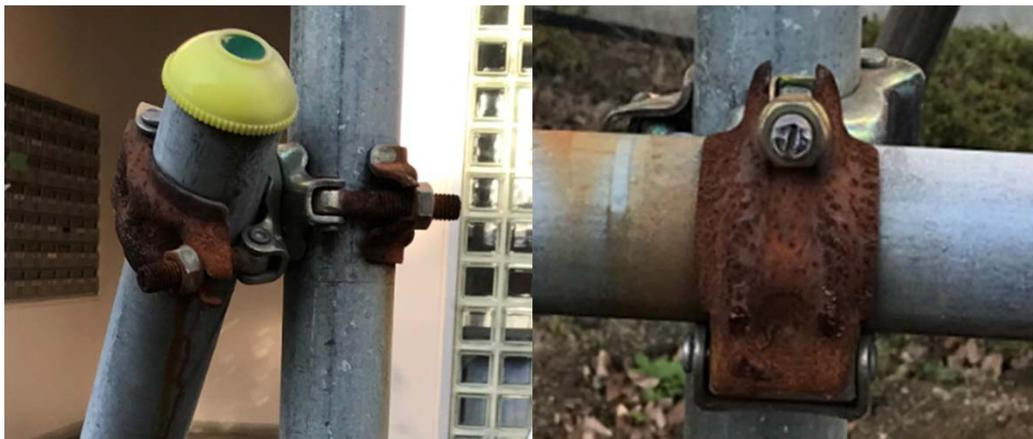
既存の単管を使用する際は、単管接続部品（クランプ）の交換をすること
