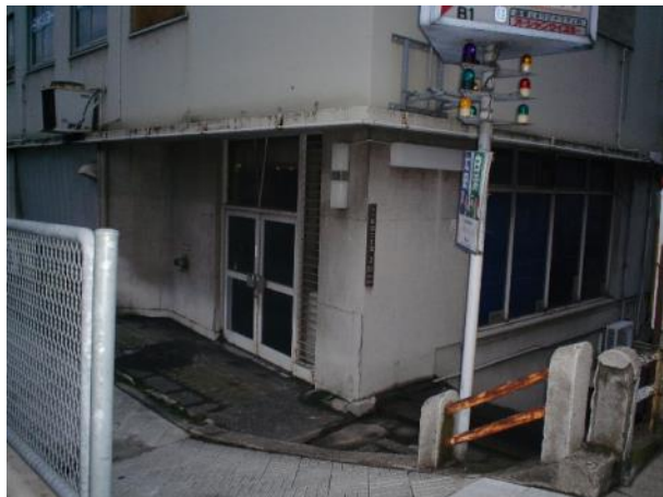
写真 3-25 路面店舗の出入口（外側）
