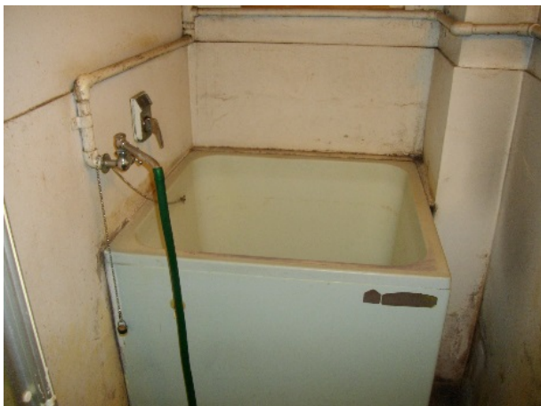
写真 4-52 FRP製の浴槽例（304号）
