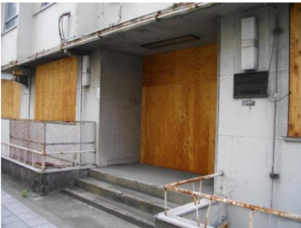
写真3-16 1階南棟中央（外側から）
