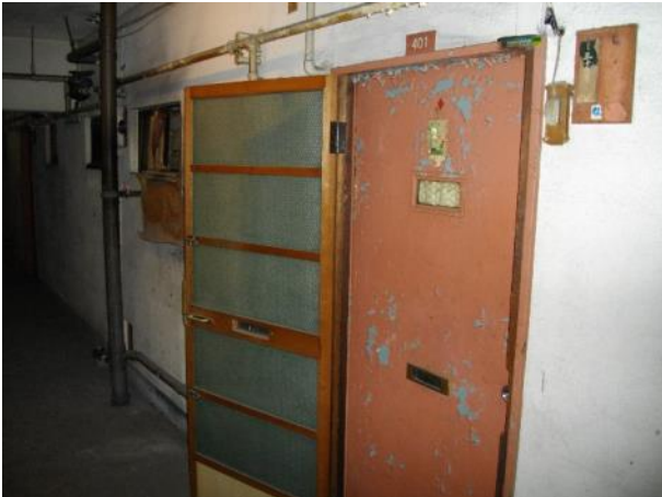
写真 4-37 自前で網戸がつけられた玄関扉(401号)
