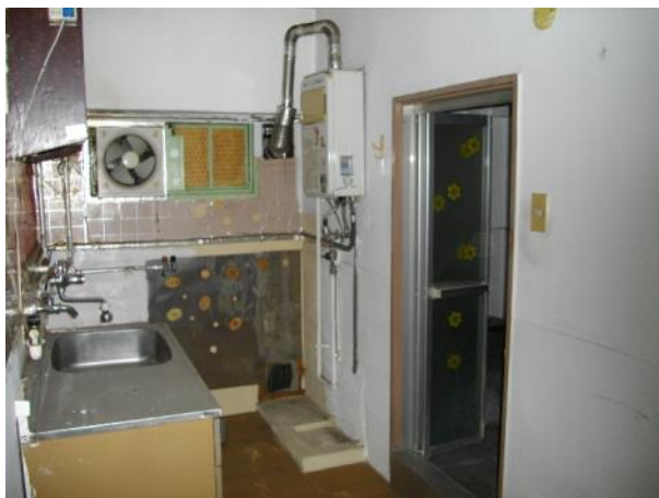
写真 4-73 給湯器の設置例 (418号)
