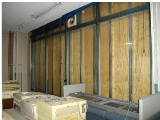
写真 3-27 路面店舗の窓（嵌め殺し窓・内側） （現在は外から板が張られている）
