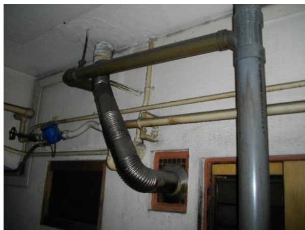
写真 4-69 排気ダクトや下水配管等 (201号)
