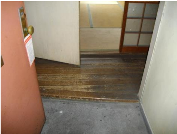
写真 4-9 玄関框が斜めに切られた簡単なデザイン
