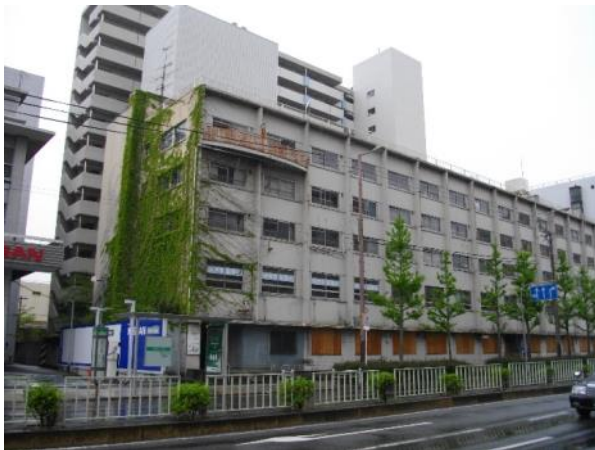
写真 4-64 バルコニー外観
