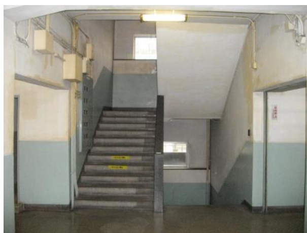
写真 3-31 南棟中央階段（1階）
