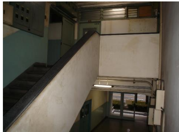
写真3-17 1階南棟中央（内側から）
