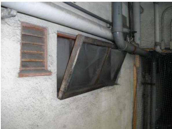
写真 4-66 中廊下側に面する台所の窓 (315号)
