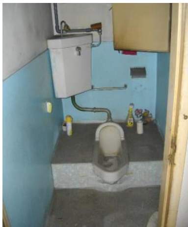
写真 4-47 トイレの例 (411号)
