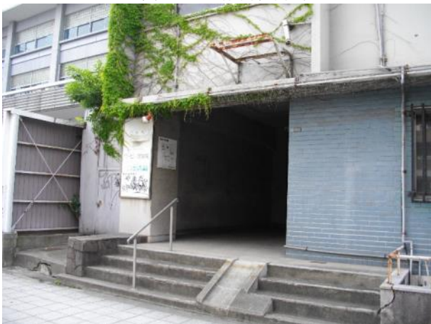
写真 3-22 1 階南棟南端入口
