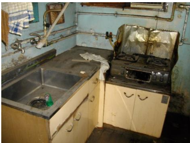
写真 4-43 現状の流し(411号)
