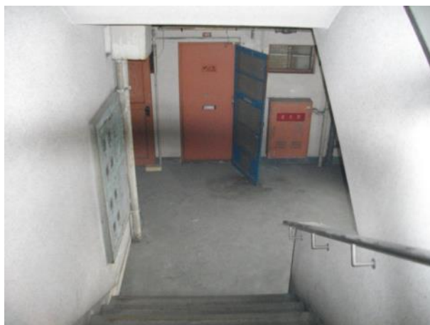
写真 3-29 南棟南端階段（4階）
