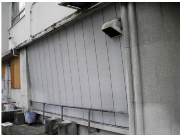
写真 3-26 路面店舗ショーウィンドウ（外側） （現在はパネルで覆われている）
