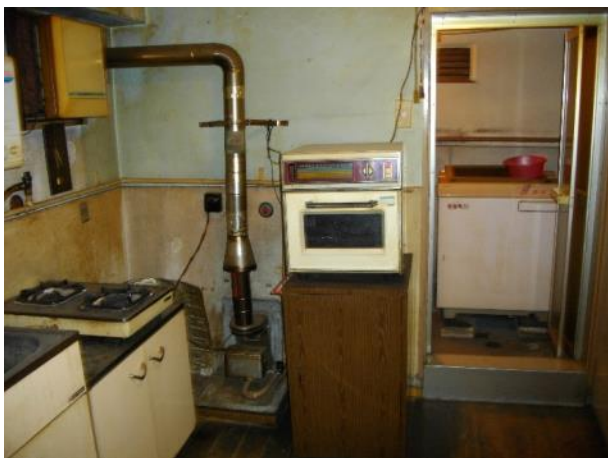
写真 4-54 台所側に露出するガス釜の例(202号)
