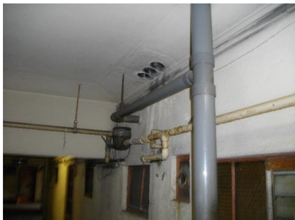
写真 4-68 天井に付近の配管 (403号)
