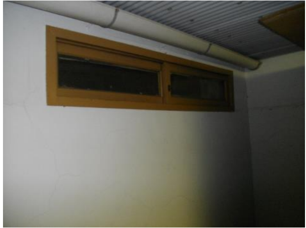
写真 3-62 現在の浴室（廊下側の小窓）
