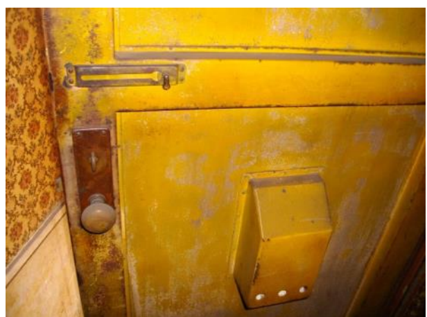
写真 4-42 玄関ノブの内側(514号)
