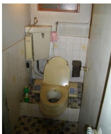
写真 4-49 トイレの例 (417号)
