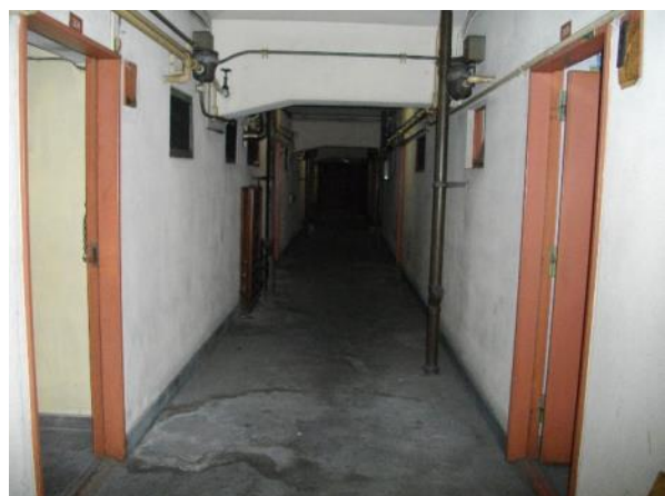
写真 4-67 窓や配管、扉等が面する2階北棟中廊下
