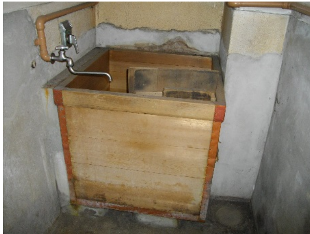
写真 4-51 木製の浴槽例（201号）
