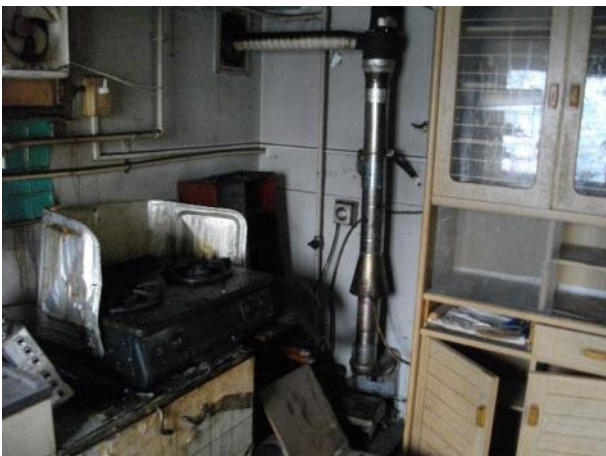
写真 4-7 台所に露出する浴室の焚き口
