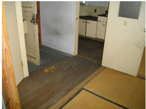
写真 4-34 玄関土間と廊下 (422号)
