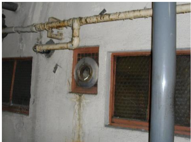
写真 4-12 中廊下側に出ている風呂釜煙突あと
