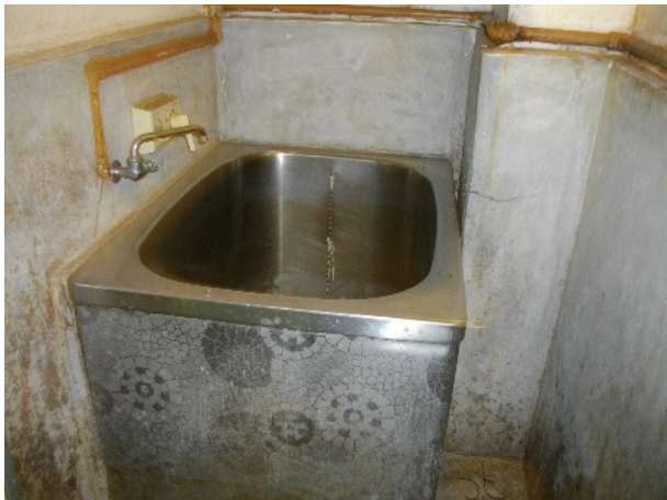
写真 4-50 ステンレスの浴槽例（203号）
