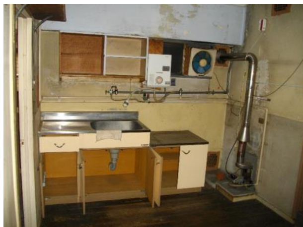
写真 4-44 現状の流し(204号)
