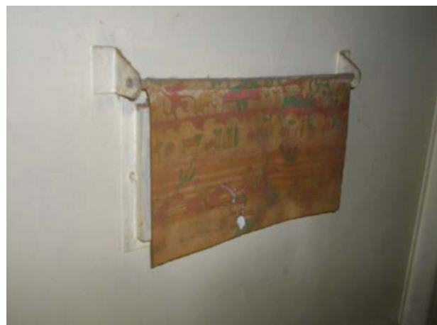
写真 4-40 小窓の内側(404号)
