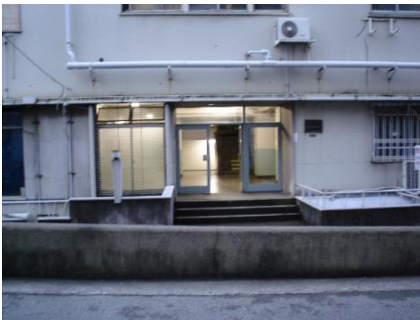
写真3-14 1階北棟西側（外側から）
