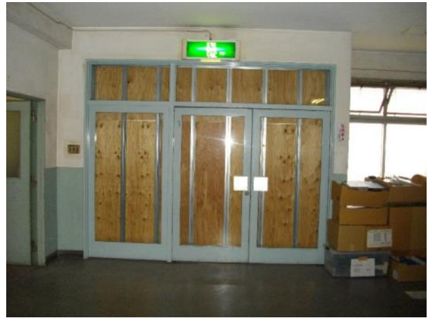
写真3-15 1階北棟西側（内側から）
