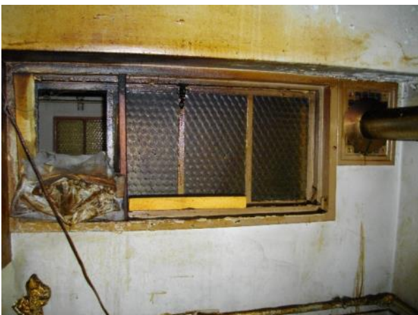
写真 4-11 台所の中廊下側の窓（風呂釜煙突が出ている）
