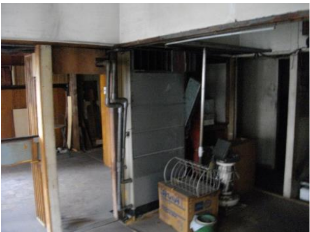
写真 4-74 業務用のクーラーが施された例 (318号)
