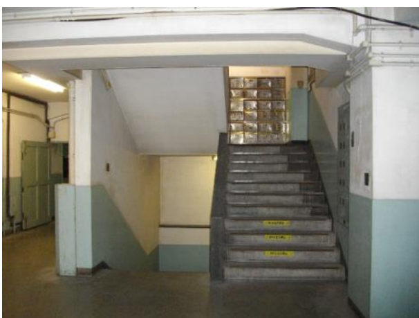
写真 3-30 北棟と南棟の交差部階段（1階）
