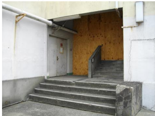
写真 3-23 1 階北棟西端入口
