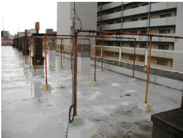
写真 3-41 屋上の物干し
