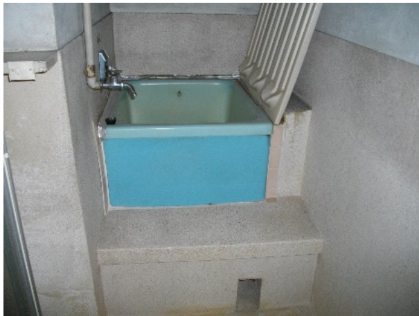
写真 4-53 踏み台が施された浴槽例（410号）
