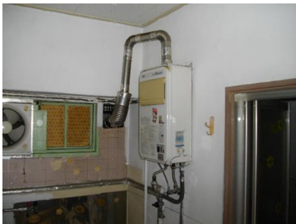
写真 4-55 給湯器に交換し風呂と流しに給湯する例(418号)
