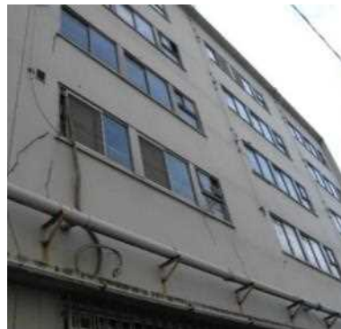
写真 3-9 北棟外観詳細
