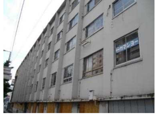
写真 3-7 北棟 2階から5階の袖壁
